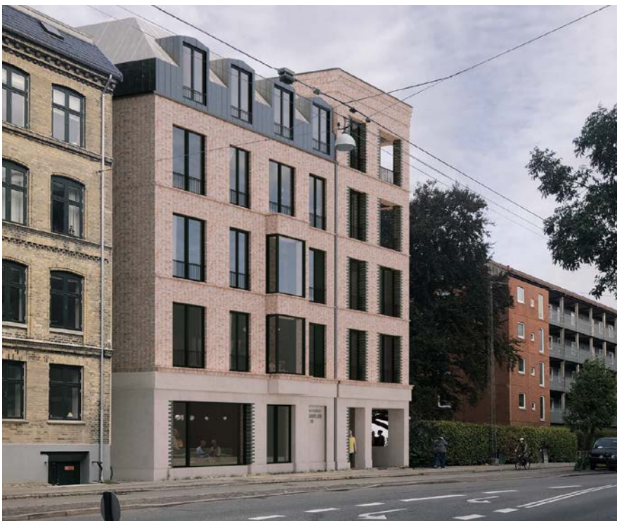
Visualisering den nye bebyggelse facade og placering på projektområdet. Murede facade udført med blødsrøgen mursten med flammert spil af varme nuancer med lysegrå trykket fuger. Taget et beklædt med forpatineret zink.
