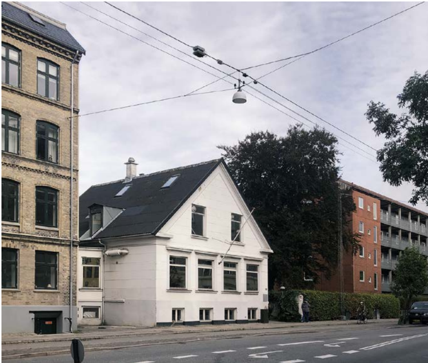
Den eksisterende erhvervsejendom på Nordre Fasanvej 99, som forudsættes nedrevet med lokalplanen samt naboejendommene nr. 97 og 103 og den bevaringsværdige blodbøg.
