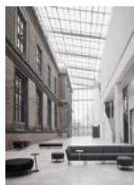
Statens Museum for Kunst, C.F. Møller Hierarki i tagkonstruktionen, der viser det nye konstruktive princip. Vi ønsker i det nye glastag tydeligt at differentiere mellem det bærende og det bårne
