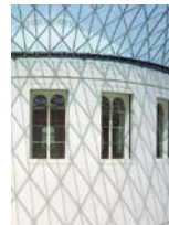
British museum of Art, FOSTER+PARTNERS Et tungere sideprofil fritholdt fra facaden danner overgang mellem den eksisterende bygning og det lette glastag. Vi ønsker at overføre dette motiv til det nye glastag i form af en visuelt tungere tagrende, der møder den luftige tagkonstruktion.
