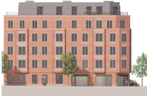
Gadefacade mod Nordre Fasanvej.
